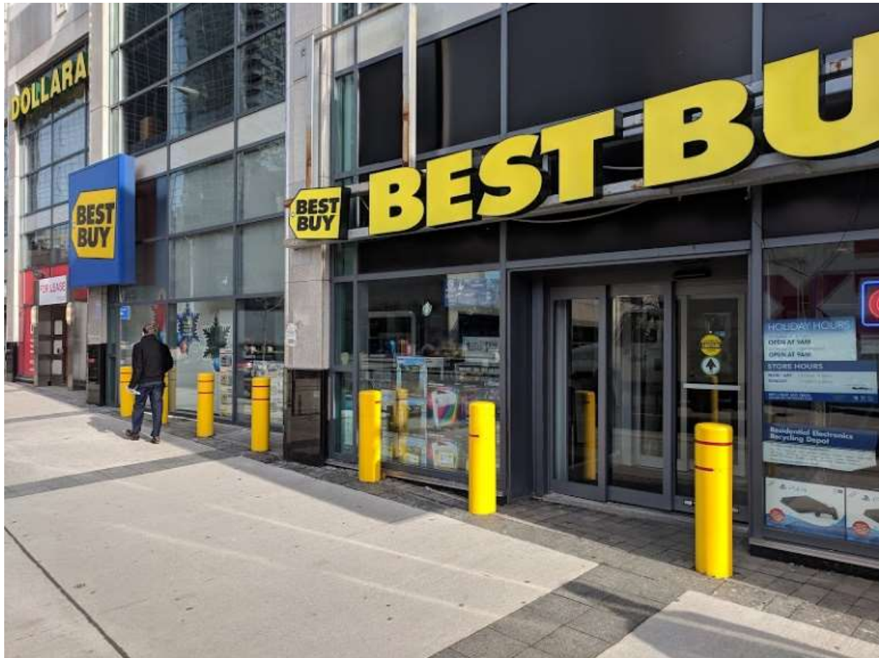
Figure 8 – Exemple d’un moyen de réduction du risque aux cibles vulnérables, des bollards de ciment protègent cette devanture de magasin d’attaques véhiculaires, mais même si le bâtiment est protégé, les piétons demeurent exposés, rue Yonge, Toronto, datée du 29 novembre 2018. Photo par Jack Rozdilsky.
